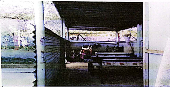
Foto 3: cambio de piso rustico por piso ceramico
