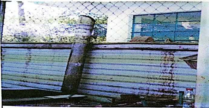
Foto1: sustitución de pared de lamina por pared de block
