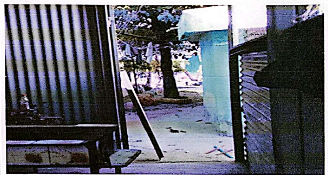
Foto 4: Sutitucion de puerta de lamina, por puerta de metal.
